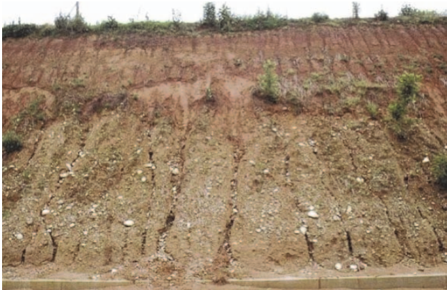
Figure 17. Talus ayant subi l'érosion
