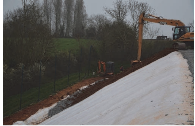
Figure 16. Mise en œuvre de la terre végétale directement sur le géotextile
