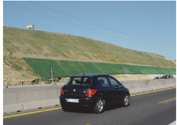
Figure 18. Talus protégé par un géosynthétique anti-érosion
