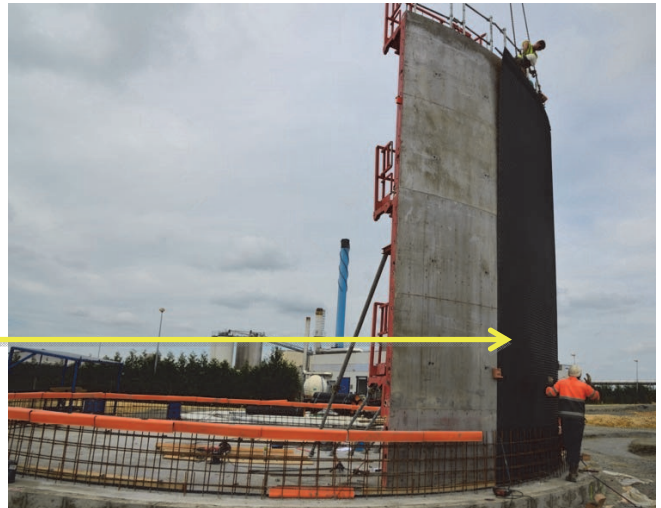
Figure 6. Etanchéité adhérente au béton
